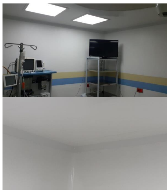
Techos con ángulos sanitarios para evitar contaminación en quirófano, esterilización, recuperación.
